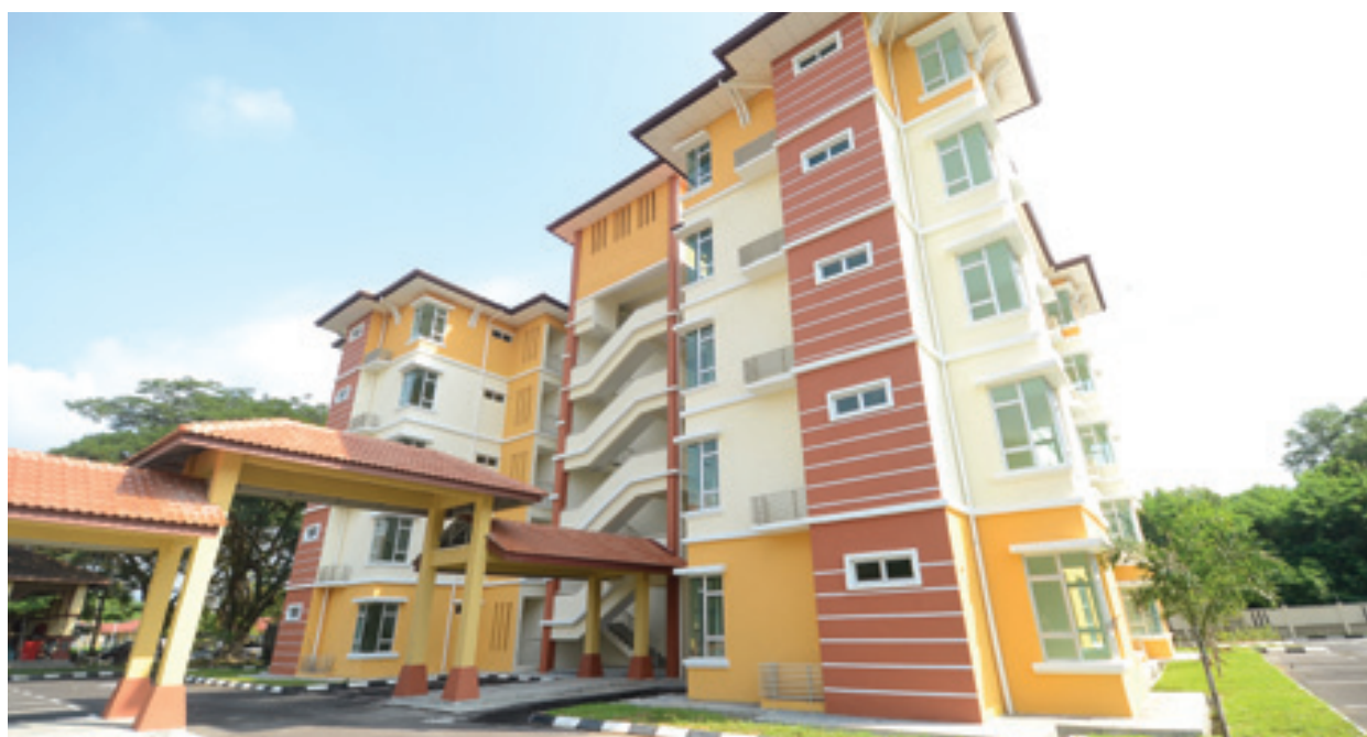
Bangunan kuarters di Darul Kifayah
