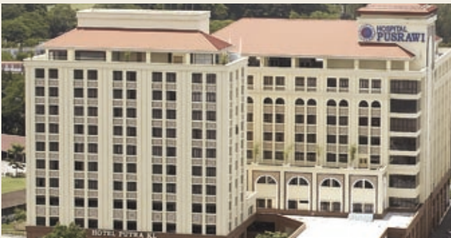
Kompleks Hospital PUSRAWI dan Hotel Putra KL
