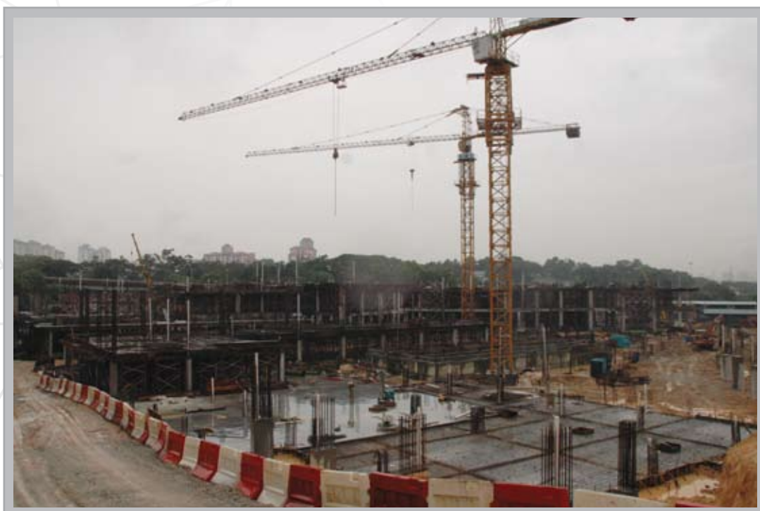
Kerja-kerja pembangunan Sekolah Menengah Agama MAIWP di Bandar Sri Permaisuri, Cheras sedang giat dijalankan
