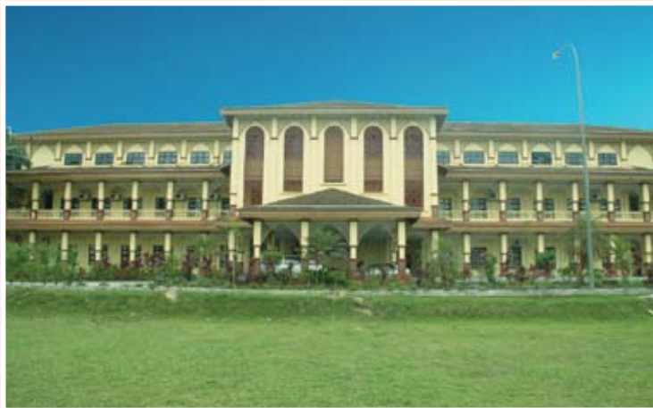
Bangunan Kompleks Darul Kifayah The building of Darul Kifayah Complex
