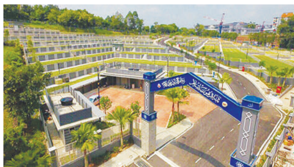
Tanah Perkuburan Islam Raudhatul Sakinah Bukit Kiara Fasa 2 yang telah siap.
