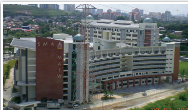
Bangunan baru SMA-MAIWP yang telah siap dibina
